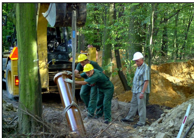
Budowa kolektora sanitarnego Witaszyczki- Jarocin.
